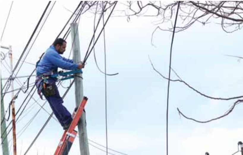
El plantel exterior realiza las tareas de expansión de la red de fibra óptica.
